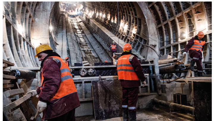
Возведение крепи эскалаторного тоннеля
